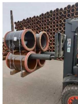
À la livraison, contrôler les tuyaux, les pièces moulées et les raccords pour s'assurer que les composants correspondent aux matériaux commandés sur le bordereau de livraison.
