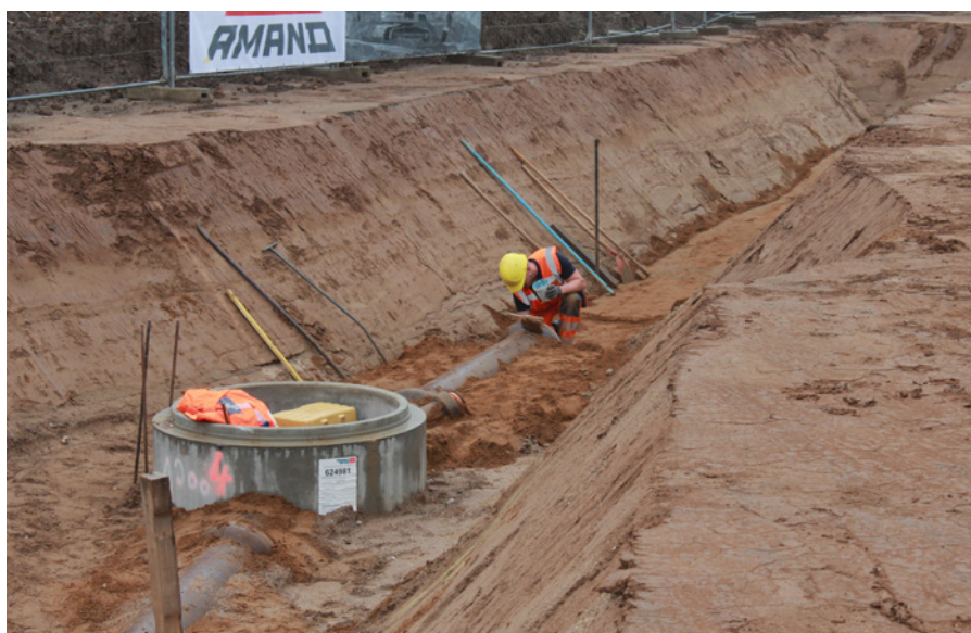
Bild 4: Die Verlegearbeiten werden von der AMAND BAU NRW GmbH & Co. KG durchgeführt
