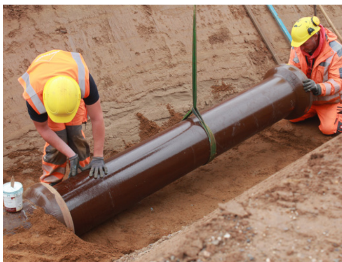
Bild 2 und Bild 3: Verlegung der 2,50 m langen Steinzeugrohre DN 300 von Euro Sweillem
